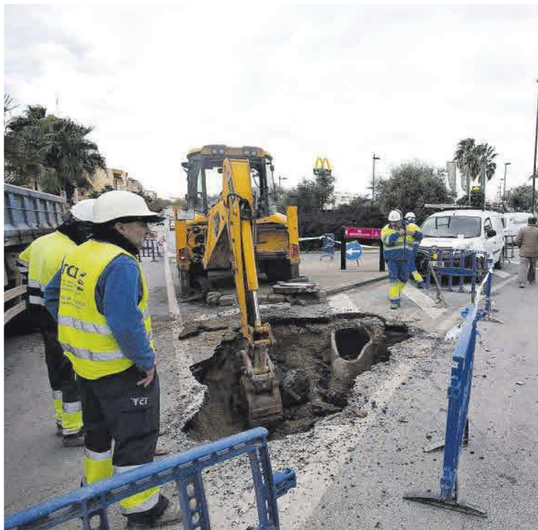
Operarios de Aqualia arreglan una avería en una tubería de Eivissa.
