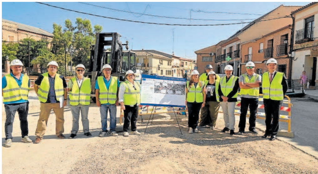
Visita a las obras de canalización del arroyo Sangüesa en Cebolla // ABC
